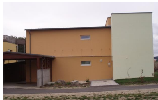
Nordseite eines Passivhauses kleine und wenige Glasflächen
